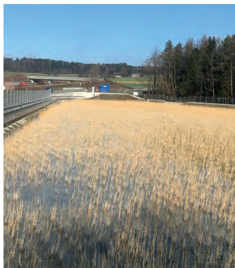
Abbildung 36 Strassenabwasser-Behandlungsanlage (SABA) in Zürich-Affoltern.
